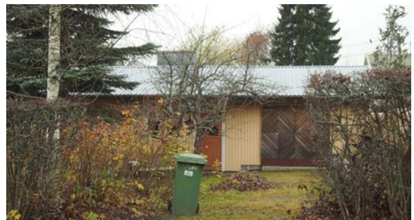
Rakennus nro (2). Nykyinen ja alkup. käyttö: talousrakennus. Rak.: 1900-l. alku. Korjausvuodet: 1960- ja -90-l. Rungon muoto: suorakaide. Kerrosluku: 1. Sokkeli: harkko. Runko: rankorakenne. Julkisivumateriaali: pystylauta. Katemateriaali: profiilipelti Katto: harja.
