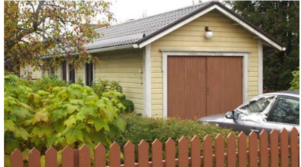
Rakennus nro 2. Nykyinen ja alkup.käyttö: talousrakennus. Rak: 1985. Rungon muoto: suorakaide. Kerrosluku: 1. Sokkeli: harkko. Runko: ranka. Julkisivumateriaali: vaakapaneli. Katemateriaali: profiilipelti. Katto: harja.
