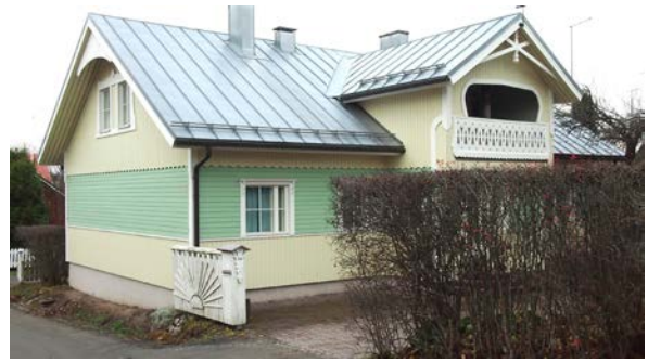
Rakennus (3). Nykyinen ja alkup. käyttö: asuinrakennus. Rak: 1990-l. Rungon muoto: suorakaide. Kerrosluku: 1. Sokkeli: harkko. Runko: rankorakenne. Julkisivumateriaali: seinien alaosat pystypanelia, keskiosa vaakapanelia ja yläosat pystypanelia. Katemateriaali: kones.pelti. Katto: harja. Kuistin muoto: umpikuisti.
