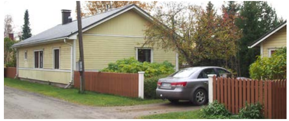
Rakennus nro 1. Nykyinen ja alkuperäinen käyttö: asuinrakennus. Rak.vuosikymmen: 1980. Rungon muoto: suorakaide. Kerrosluku: 1. Sokkeli: harkko. Runko: rankorakenne. Julkisivumateriaali: ikkunoiden välit vaakapanelia ja päätykolmiot ja julkisivujen alaosa ovat pystypanelia. Katemateriaali: profiilipelti. Katto: harja. Kuistin muoto: avokuisti.
