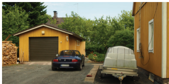
Rakennus nro 2. Nykyinen ja alkup. käyttö: talousrakennus. Rak. -. Rungon muoto: suorakaide. Kerrosluku: 1. Sokkeli: harkko. Runko: rankorakenne. Julkisivumateriaali: pystylauta rimoituksella. Katemateriaali: pelti. Katto: harja.
