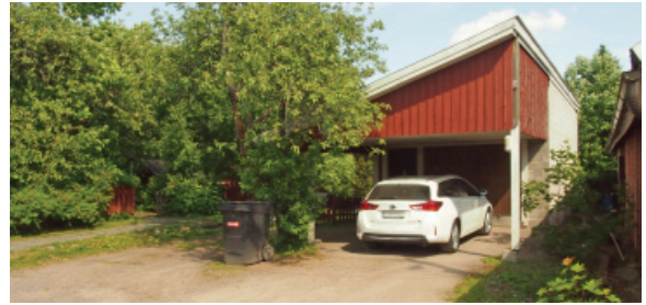
VII Linja nro 7:n moderni piharakennus.
