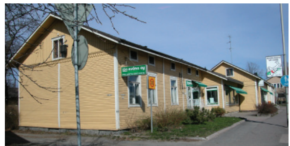
Sama rakennus v. 2008.
