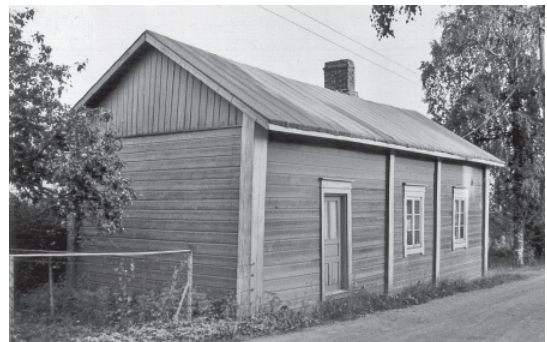
Purettu rakennus I linja nro 3 , 1970 -luvulla.
