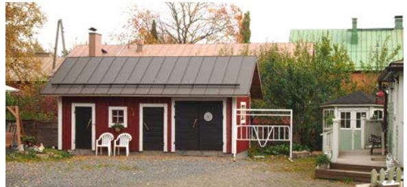
Rakennus nro 2, talousrakennus
