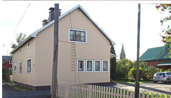
Rakennus nro 1. Nykyinen ja alkup. käyttö: asuinrakennus. Rak.vuosisat: 1800-l. loppu (ydinosa). Korjausvuodet: 1947, 1968, 1984 ja 1989. Rungon muoto: suorakaide. Ullakko: on. Kerrosluku: 1. Sokkeli: luonnonkivi /betonipinnoitus. Runko: hirsi. Julkisivumateriaali: pystyaukkoitus peiterimoilla. Katemateriaali: konesaumattu pelti. Katto: harja. Kuistin muoto: avokuisti.
