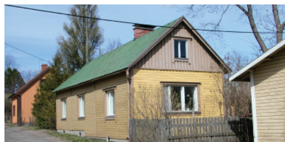
Rakennus nro 1. Nykyinen käyttö: asuinrakennus. Alkup. käyttö: asuinrakennus. Rak. (pääosa) 1800 -l. lopulla. Korjausvuodet: 1984. Rungon muoto: suorakaide. Kerrosluokka: 1. Ullakko: on. Sokkeli: lohkokivi Runko: lamasalvos. Julkisivumateriaali: vaakapaneli ja päätykolmiot lomalaudoitusta. Katemateriaali: konesaumattu pelti. Katto: harja. Kuistin muoto: umpikuisti. Kuistin katto: pulpetti. Asuinrakennukseen alueen kannalta tärkeä luokka 2: rak/s. Rakennus vastaa mitatakaavaltaan varhaisinta kerrostumaa. Osa rakennuksesta kuuluu todennäköisesti palstoitetun Kalliomäen vanhimpaan kerrostumaan.
