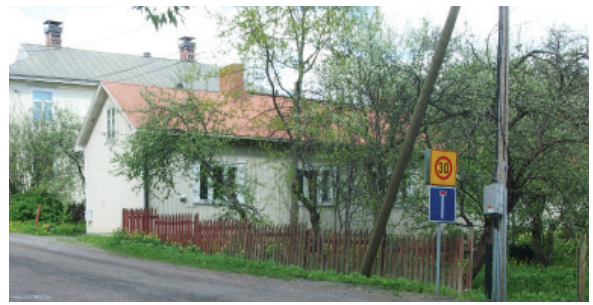
Rakennus sijaitsee poikittain loivalla rinnetontilla.
