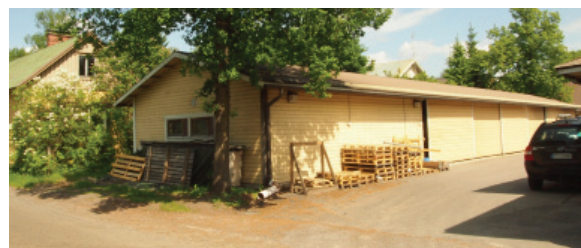
Rakennus nro 2 (varasto) yltää lähes linjalta toiselle.
