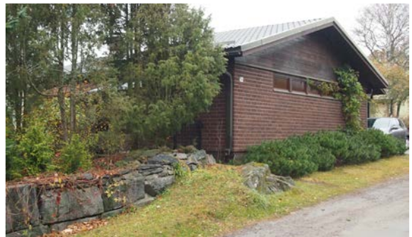
Rakennus nro 1. Nykyinen käyttö: asuinrakennus. Alkup. käyttö: asuinrakennus. Rak: 1970-l. Rungon muoto: suorakaide. Kerrosluku: 1. Sokkeli: betoni. Runko: rankorakenne. Julkisivumateriaali: tiili. Katemateriaali: profiilipelti. Katto: harjakatto.
