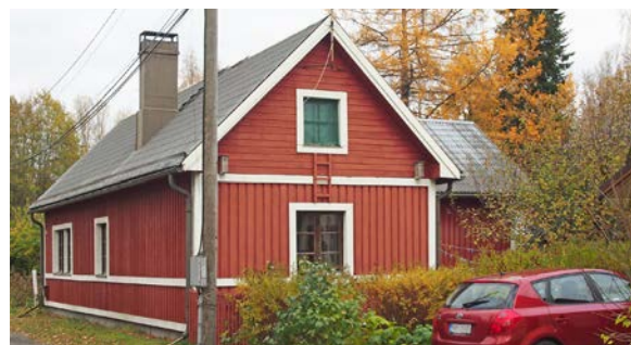
Rakennus nro 1. Nykyinen käyttö: asuinrakennus Alkup. käyttö: asuinrakennus. Rak.vuosisata: 1800-l. Korjausvuodet: Rungon muoto: T-muoto. Kerrosluku: 1 + matala ullakko. Sokkeli: verhottu kiviaineslevyllä. Runko: hirs. (Laajennusosa: rankorakenne). Julkisivumateriaali: pystylauta, päätykolmiot vaakapanelia. Katemateriaali: pelti. Katto: harja. Kuistin muoto: katos.
