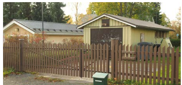
Rakennus nro 2. Nykyinen ja alkup.käyttö: talousrakennus. Rak: 1979. Rungon muoto: suorakaide. Kerrosluku: 1. Sokkeli: harkko. Runko: ranka. Julkisivumateriaali: lomalauta. Katemateriaali: profiilipelti. Katto: harja.
