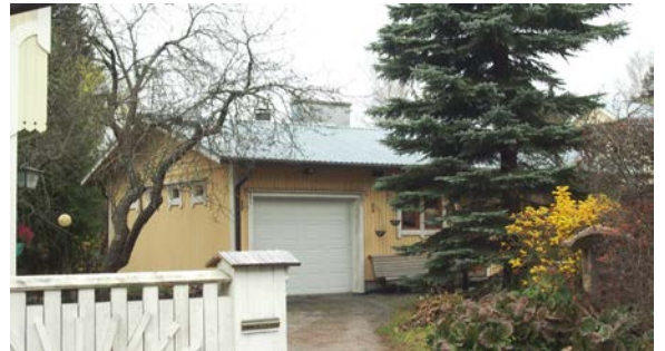
Rakennus nro (2). Nykyinen ja alkup. käyttö: talousrakennus. Rak.: 1900-l. alku. Korjausvuodet: 1960- ja -90-l. Rungon muoto: suorakaide. Kerrosluku: 1. Sokkeli: harkko. Runko: rankorakenne. Julkisivumateriaali: pystylauta. Katemateriaali: profiilipelti Katto: harja.
