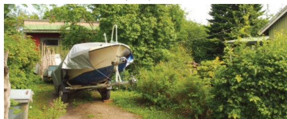
Rakennus nro 2. Nykyinen ja alkup. käyttö: talousrakennus. Rak. 1960-l. Korjausvuodet: -. Rungon muoto: suorakaide. Kerrosluku: 1. Sokkeli: betoni. Runko: rankorakenne. Julkisivumateriaali: pystylauta. Katemateriaali: pelti. Katto: pulpetti.
