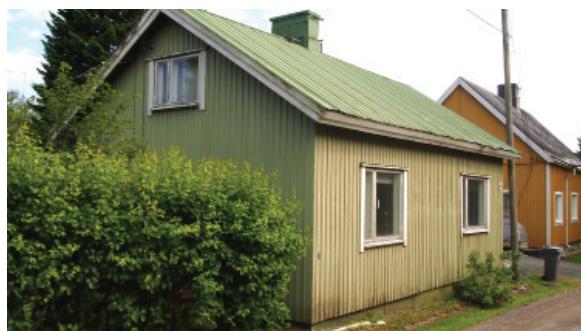
Rakennus nro 1. Nykyinen käyttö: asuinrakennus. Alkup. käyttö: asuinrakennus. Rak.: 1900-l. alkupuoli. Korjausvuodet: 1940. Rungon muoto: suorakaide. Kerrosluku: 1. Sokkeli: kivet, peitetty levyllä. Runko: hirsi. Julkisivumateriaali: pystylauta peiterimoilla. Katemateriaali: profiilipelti. Katto: harja. Asuinrakennukseen alueen kannalta tärkeä luokka 2: rak/s. Rakennus sijoittuu alkuperäisen rakentamistavan mukaisesti kadun varteen, on matala ja kapearunkoinen.
