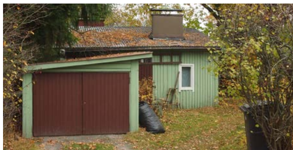
Rakennus nro 2. Nykyinen ja alkup. käyttö: talousrakennus. Rak.vuosisata: 1900 -l. alku ja 60-luku. Rungon muoto: L -muoto. Kerrosluku: 1. Sokkeli: betoni. Runko: ranka. Julkisivumateriaali: pystylauta peiterimoilla. Katemateriaali: profiilipelti. Katto: harja / pulpetti.
