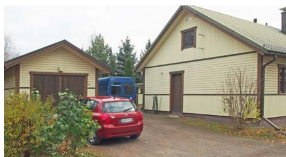
Rakennus nro 1. Nykyinen ja alkuperäinen käyttö: asuinrakennus. Rak.vuosikymmen: 1980. Rungon muoto: suorakaide. Kerrosluku: 1. Sokkeli: harkko. Runko: rankorakenne. Julkisivumateriaali: ikkunoiden välit vaakapanelia ja muutoin julkisivut ovat pystypanelia. Katemateriaali: profiilipelti. Katto: harja. Kuistin muoto: umpikuisti.
