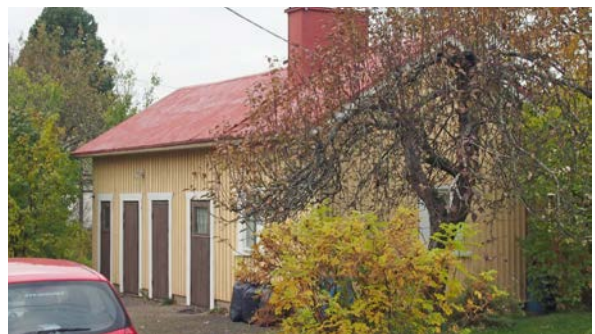
Rakennus nro 1. Nykyinen ja alkup. käyttö: asuinrakennus. Rak.vuosisata: 1800-l. loppu. Korjausvuodet: ? . Rungon muoto: suorakaide. Kerrosluku: 1 ja ullakko. Sokkeli: betonoitu. Runko: lamasalvos. Julkisivumateriaali: pystylauta peiterimoilla. Katemateriaali: profiilipelti. Katto: harja. Kuistin muoto: umpikuisti.
