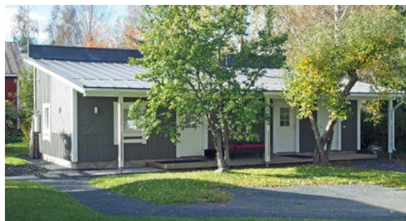
Rakennus nro 2. Nykyinen ja alkup. käyttö: talousrakennus. Rak.vuosikymmen: 2010 -luku. Rungon muoto: suorakaide. Kerrosluku: 1. Sokkeli: rapattu harkko. Runko: rankarakenne. Julkisivumateriaali: pystyaukkoitus peiterimoilla, osin vinolaukoitus. Katemateriaali: pelti. Katto: harja.
