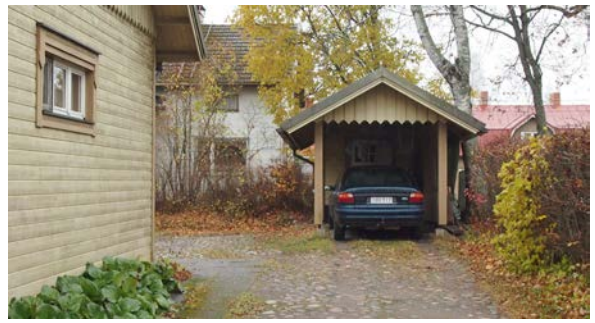
Rakennus nro 2. Nykyinen ja alkup. käyttö: talousrakennus. Rak.vuosikymmen: 1980. Korjausvuodet: -. Rungon muoto: suorakaide. Kerrosluku: 1. Sokkeli: betoni. Runko: ranka. Julkisivumateriaali: lomalauta. Katemateriaali: profiilipelti. Katto: harja.
