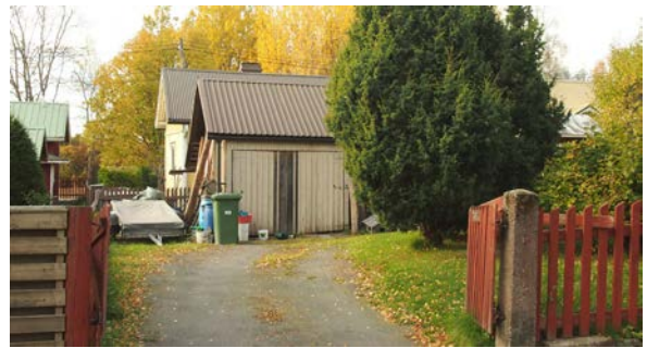
Rakennus nro 2. Nykyinen ja alkup.käyttö: talousrakennus. Rak: -. Rungon muoto: suorakaide. Kerrosluku: 1. Sokkeli: kivet. Runko: ranka. Julkisivumateriaali: pystylauta peiterimoilla. Katemateriaali: profiilipelti. Katto: harja.
