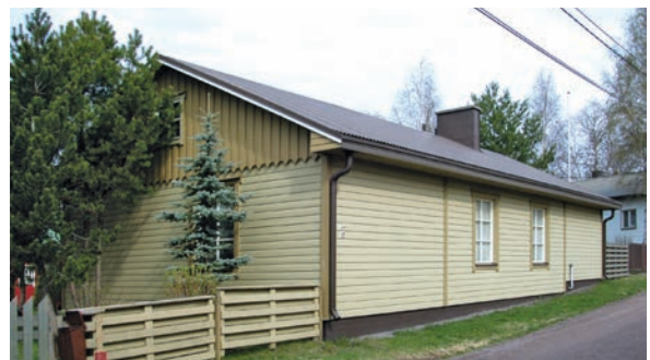
Rakennus nro 1. Nykyinen ja alkuperäinen käyttö: asuinrakennus. Rak.vuosikymmen: 1980. Rungon muoto: suorakaide. Kerrosluku: 1. Sokkeli: betoni. Runko: rankorakenne. Julkisivumateriaali: Vaakapaneli ja päätykolmiot pystylautaa. Katemateriaali: profiilipelti. Katto: harja. Kuitin muoto: umpikuisti.
