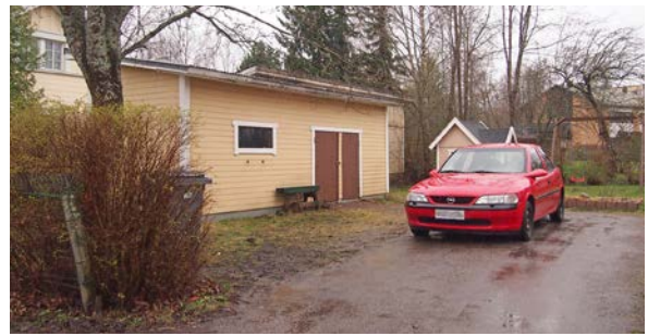
Rakennus nro 2. Talusrakennus. Rak: 1950-luku? Rungon muoto: suorakaide. Kerrosluvu: 1. Sokkeli: betoni. Runko: ran- korakenne. Julkisivumateriaali: vaakapaneli. Katemateriaali: profiilipelti. Katto: harja.
