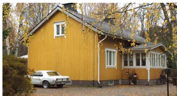
Rakennus nro 1. Nykyinen ja alkup. käyttö: asuinrakennus. Rak.vuosisata: 1940-l. Korjausvuodet: -. Rungon muoto: suorakaide. Kerrosluku: 1 ja ullakko. Kellari: on. Sokkeli: betoni. Runko: lamasalvos. Julkisivumateriaali: pystylauta kapeilla peiterimoilla. Katemateriaali: profiilipelti. Katto: harja. Kuistin muoto: umpikuisti.
