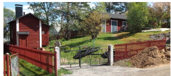
Rakennus nro 3 (sauna).
