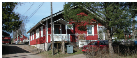
Rakennus nro 1. Nykyinen ja alkup. käyttö: asuinrakennus. Rak. n.1990. Korjausvuodet: -. Rungon muoto: suorakaide. Kerrosluku: 1. Ullakko: on. Sokkeli: harkko. Runko: rankorakenne. Julkisivumateriaali: seinän ylä- ja alaosaa pystypanelia, keskiosa vaakapanelia. Katemateriaali: profiloitu pelti. Katto: harja.
